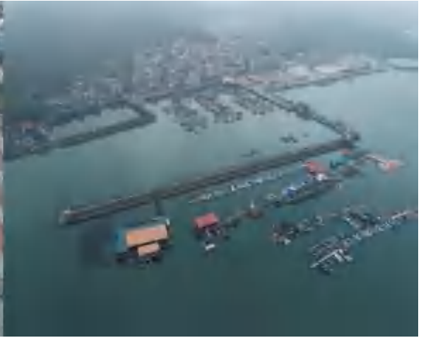
b 下西坑二级渔港防波堤及港池
