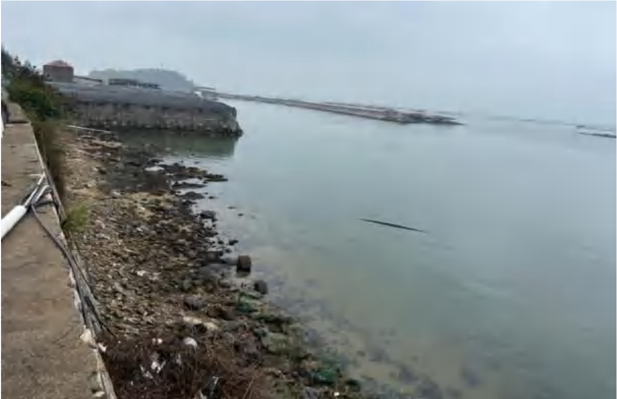
图4.2-2 项目区港池后方砂质岸线现状1
