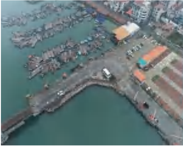
a 南防波堤接岸处陆岛交通码头
