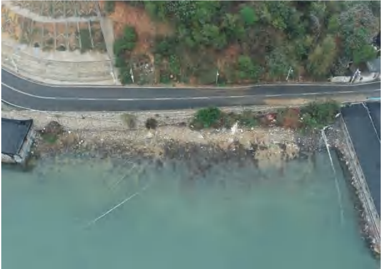
图4.2-4 项目区港池后方砂质岸线现状3
