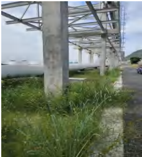
南 2 罐区围墙外
